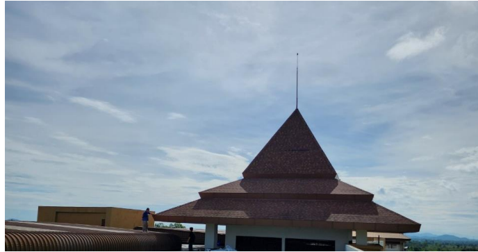
เสาล่อฟ้า
